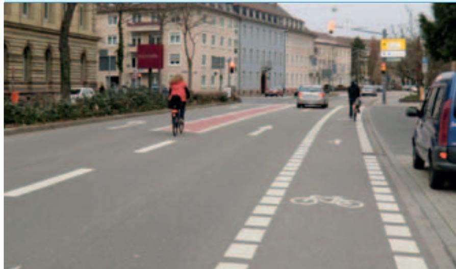
Abbiegestreifen für direkt links abbiegende Radfahrer an Knotenpunkten
