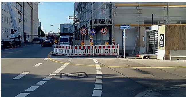
Baustelle ohne Radverkehrsführung in München © Bernadette Felsch
