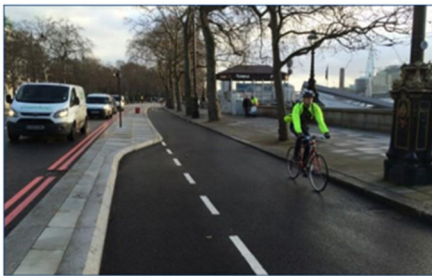
Bild 4: Transport for London (TfL) Super Cycle Highway in London (UK) Variante als Innerstadte Radschnellwegführung mit abgesenkter Bordsteinkante zur Verringerung der Sturzgefahr
